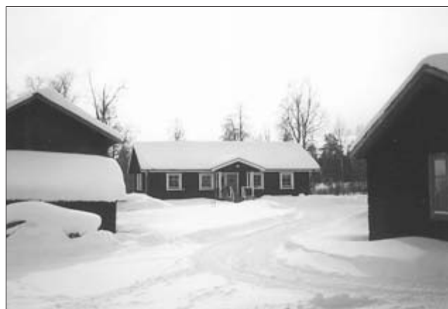
Nybyggnad i anslutning till äldre hus
